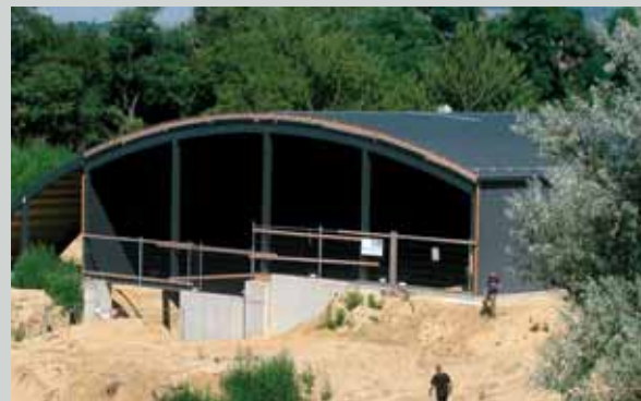
DIE HALLE schützt nicht nur das Austernriff, sondern bewahrt auch die Paläontologen vor Regen und Sonnenbrand.
